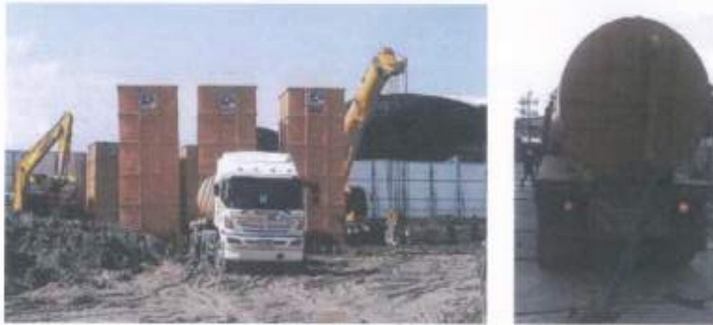
รูปที่ 2.7.1-14 ตัวอย่างการจัดการสารเบนโทไนท์ที่ใช้ในการทำเสาเข็ม
